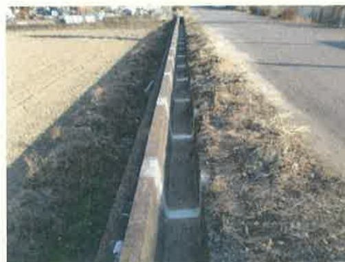
(補修後の水路)
