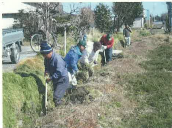
○水路の浚渫活動
